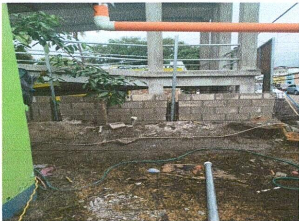
Foto1: mejoramiento de muro perimetral
