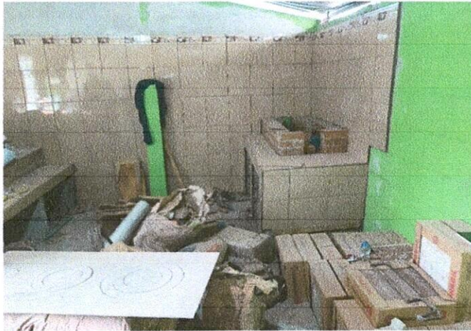
Foto1: mejoramiento de area de cocina
