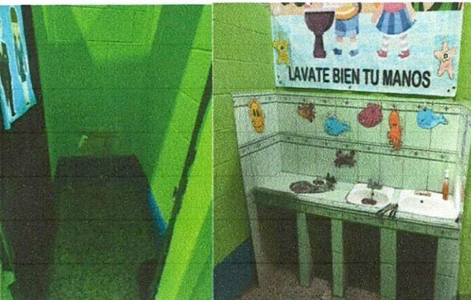
Foto 3: mejoramientos de area de servicios sanitario
