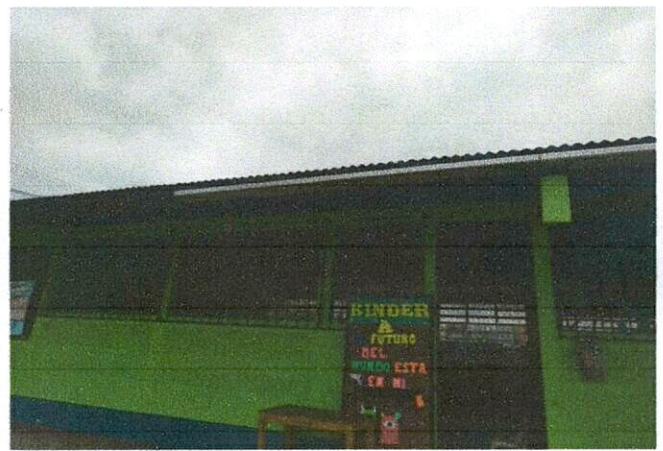
Foto 2: Mejoramiento de canales de agua pluvial
